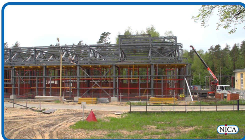
Строительство здания компрессорной станции Construction of the compressor station building
