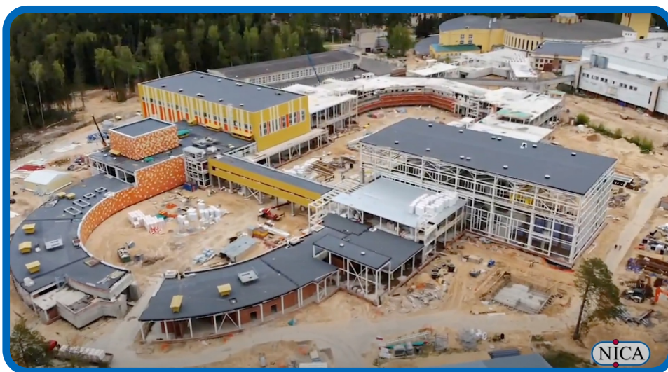
Строительная площадка проекта NICA // NICA construction site
