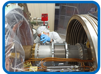
Монтаж и вакуумные испытания пучковой камеры Бустера // Installation and vacuum tests of the Booster beam pipe
